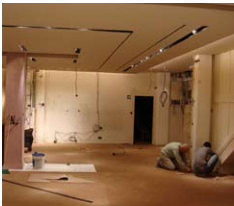
Installazione dell'arredo / Furniture set up
