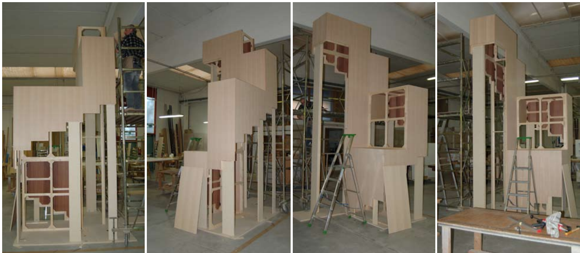
La scala in costruzione / Staircase under construction
