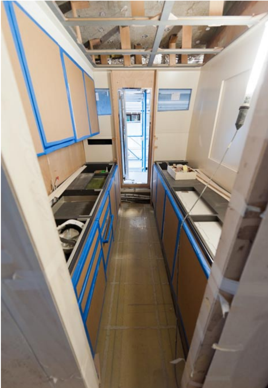
La cucina in costruzione / The kitchen under construction
