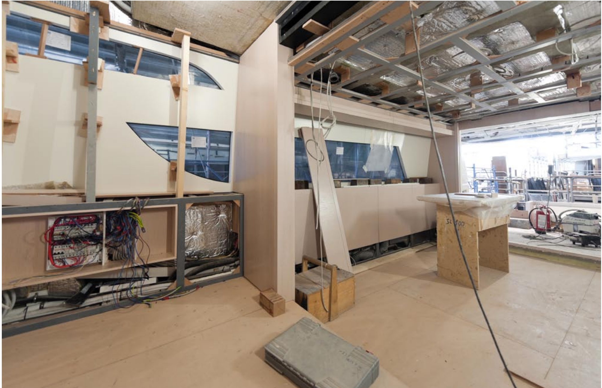
Il ponte coperta in costruzione / Main deck under construction
