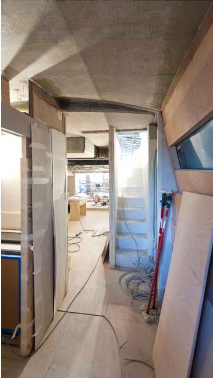
In costruzione (vista opposta) / Under construction (opposite view)
